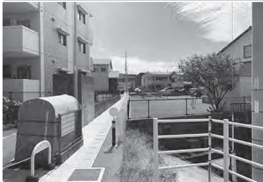
▲きれいに舗装された通路
