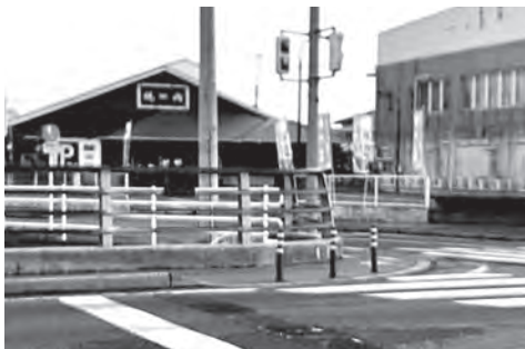
▲ 新しく設置された保護柵（タイムズ提供）
