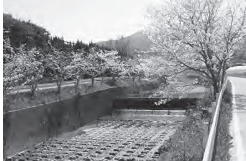
▲ しゅんせつ工事が終わった七寺川
